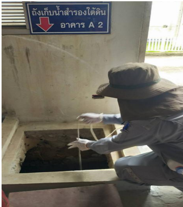
รูปที่ 1 การเก็บตัวอย่างน้ำบาดาลที่ บ่อเก็บน้ำใต้ดินตึก A
