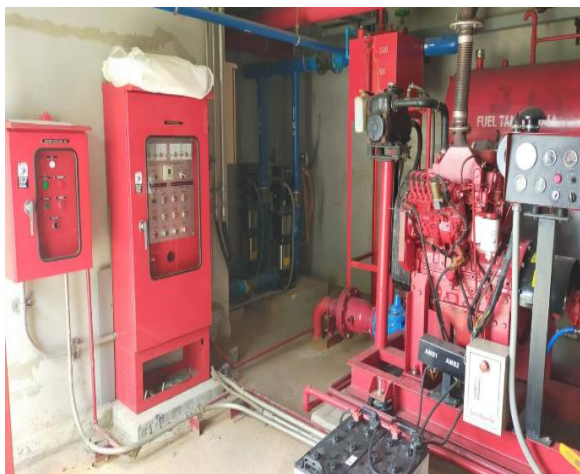
รูปที่ 4 ป้อนน้ำดับเพลิง
