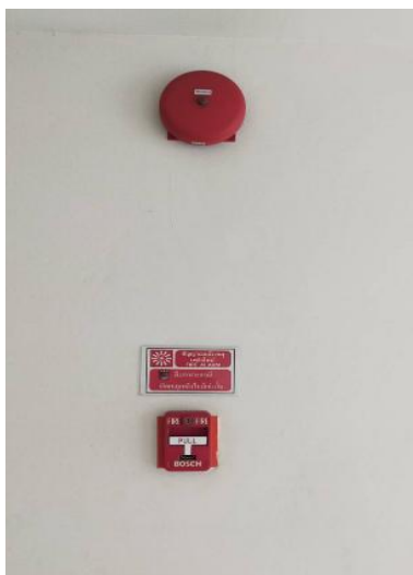
รูปที่ 2 สัญญาณแจ้งเหตุเพลิงไหม้
